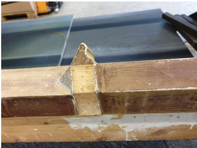
Abb. 19-21: Konstruktive Schadstellen am historischen Holzwerk. Fehlende, abgebrochene oder lose Bausubstanzen erkennbar.
